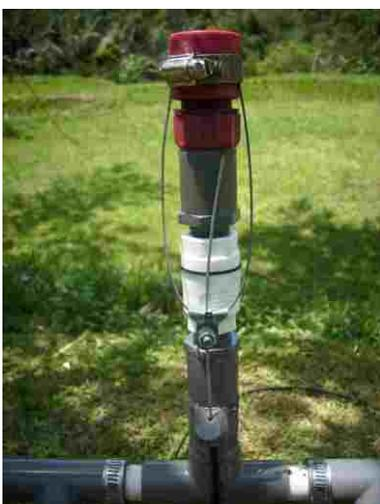
Pasang kawat kecil rem pada bagian kepala peluncur (*Hose Quick Connector*) dengan menggunakan klem ukuran 1½". Masukkan kawat tersebut ke kaitan rem besi dan sambungkan kaitan rem besi dengan kabel rem. Kencangkan dengan menggunakan tang atau obeng. Saat mengencangkan, aturlah kawat rem sehingga saat rem ditekan, kawat rem akan tertarik sehingga menarik bagian kepala peluncur. Rapihan bagian-bagian pada sambungan pipa-utama dengan menggunakan lem lilin.
